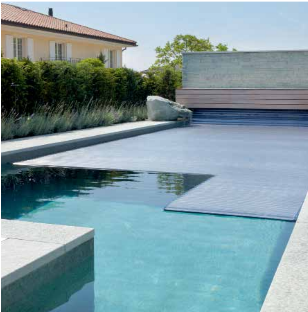
Der Living-Pool wurde mit Andeer-Granit ausgekleidet. Einer der wenigen Natursteine, die sich für den Pool-Bau eignen.
