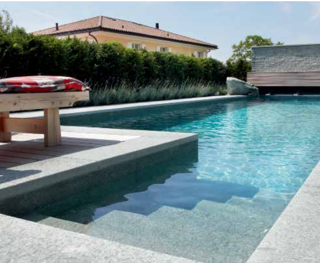
Der Living-Pool wurde mit Andeer-Granit ausgekleidet. Einer der wenigen Natursteine, die sich für den Pool-Bau eignen.
