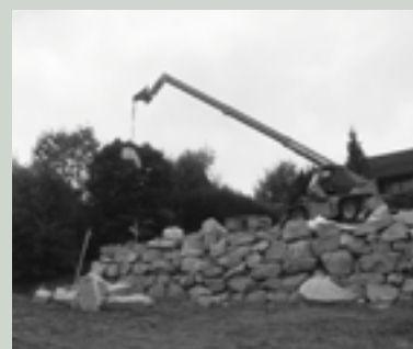
Während des Umbaus: Die neue Umfassungsmauer ist aus Schwarzwaldgranit.
