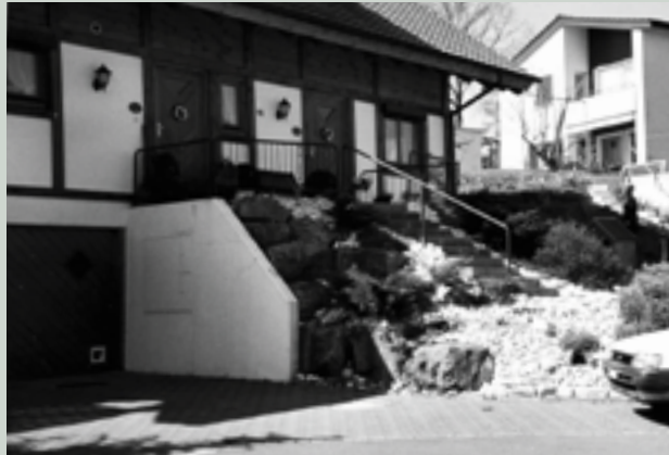
Vorher: Das Terrain des Vorgartens senkte sich ab und musste dringend umgestaltet werden.
